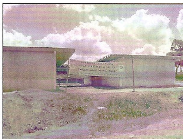
Companheiros de Itu Terras de São José acompanhando as obras da Escola Rotary
