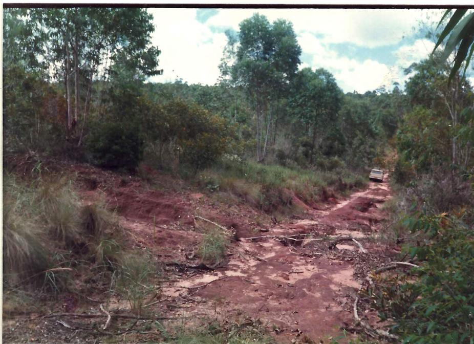
Foto 11. Detalhe do solo e da necessidade de trabalhos de recuperação e conservação de estradas e carreadores.
