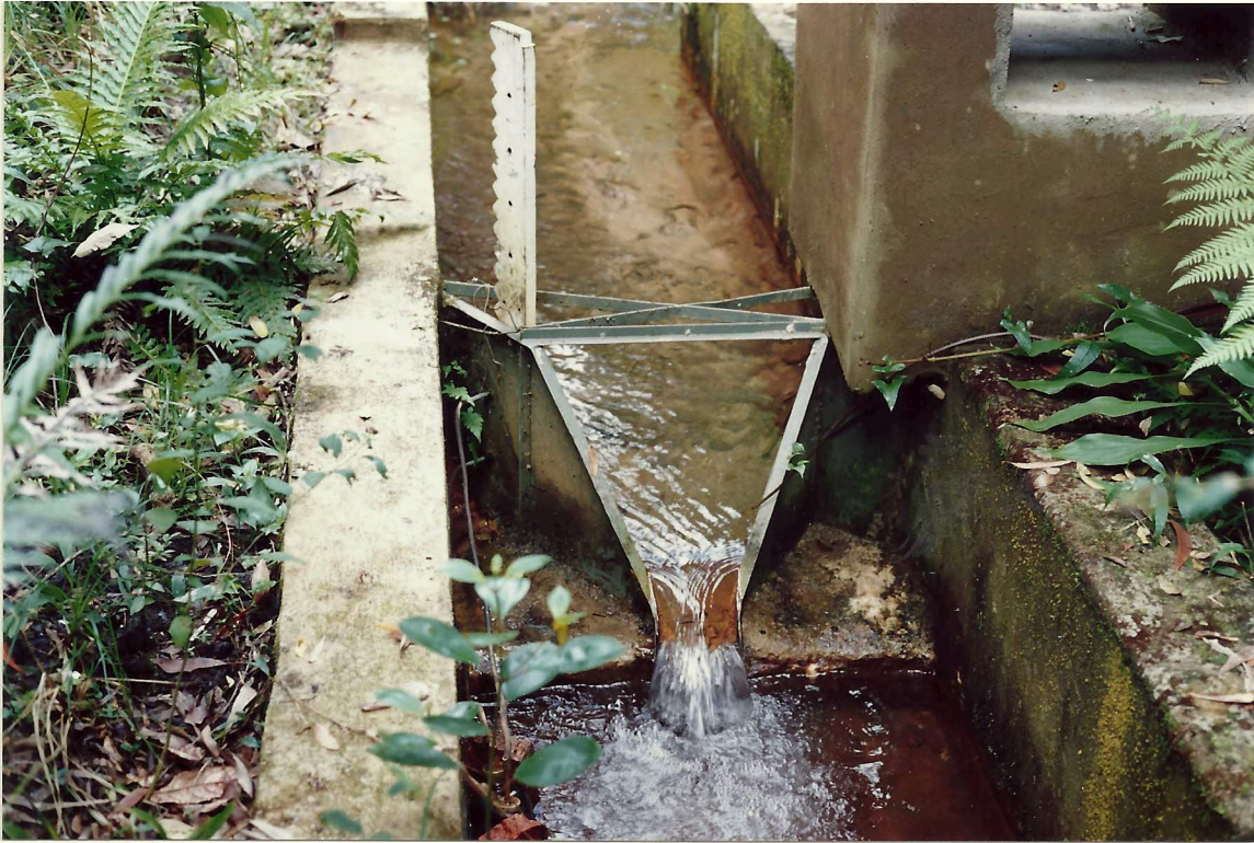
Foto 17. Vertedouro instalado no Córrego Tinga.
